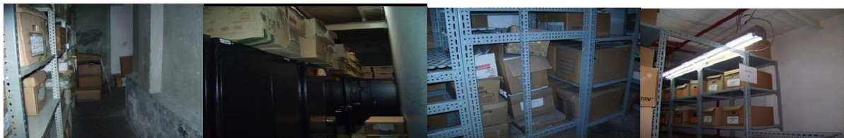
Área contacto con humedad Área sin medidas de seguridad Mobiliario viejo Instalaciones eléctricas no funcional
