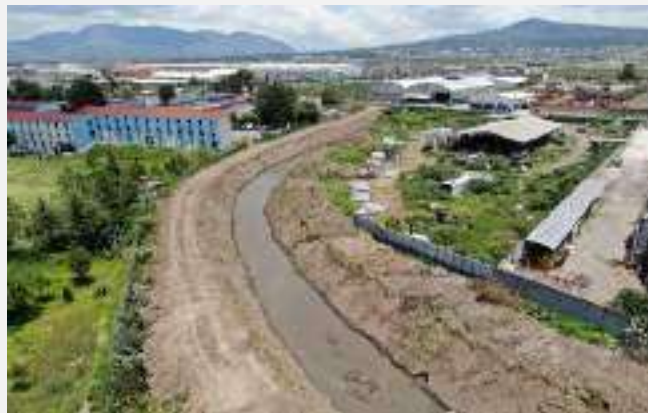
Imagen 28. Desazolve de canal
