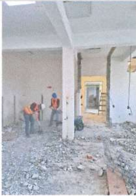
FOTO (F1).- Demolición de pisos de loseta y firmes de concreto; desmantelamiento y cancelación de instalaciones existentes; retiro de mesas, herrería: puertas, ventanas y rejas.
