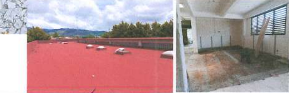
FOTO ANTES (F5). Avance trimestral: demolición estructuras existentes, preparación de superficie y desplante de muros de block, colado de cadenas y castillos.
