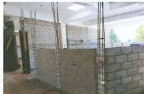
FOTO (F2).- Preparación de superficie, habilitado de acero para colado de cadenas de desplante.
