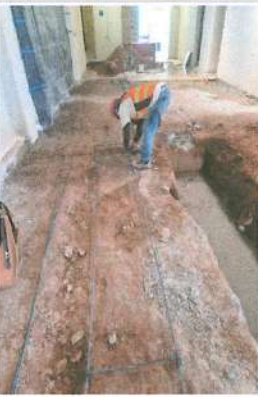
FOTO (F2).- Preparación de superficie, habilitado de acero para colado de cadenas de desplante.
