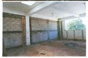
FOTO (F4). Construcción de muros de block, colado de cadenas de desplante, intermedias y de cerramiento; habilitado, armado y colado de castillos.
