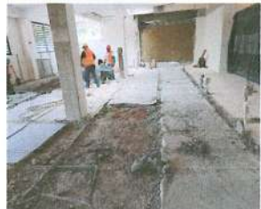
FOTO (F1).- Demolición de pisos de loseta y firmes de concreto; desmantelamiento y cancelación de instalaciones existentes; retiro de mesas, herrería: puertas, ventanas y rejas.
