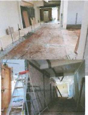
FOTO (F4). Construcción de muros de block, colado de cadenas de desplante, intermedias y de cerramiento; habilitado, armado y colado de castillos.
