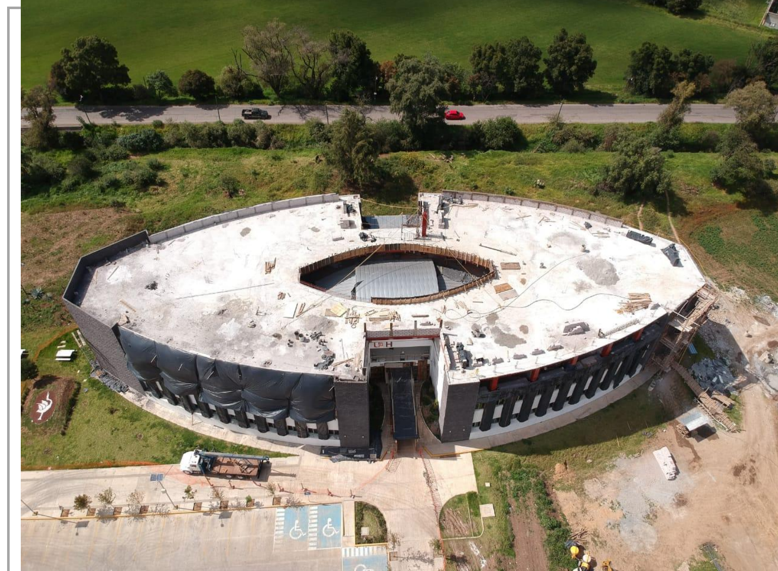
F4: COLADO DE LOSACERO (AZOTEA)
