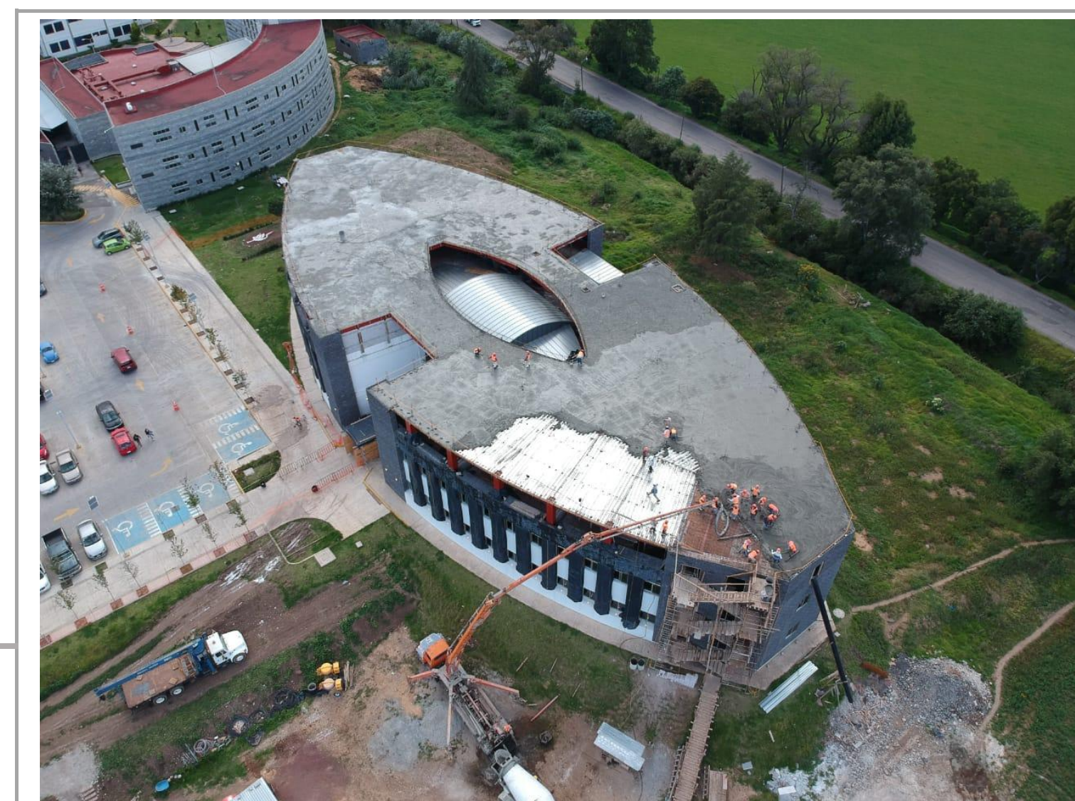
F3: TRABAJOS DE COLADO DE LOSACERO (AZOTEA)
