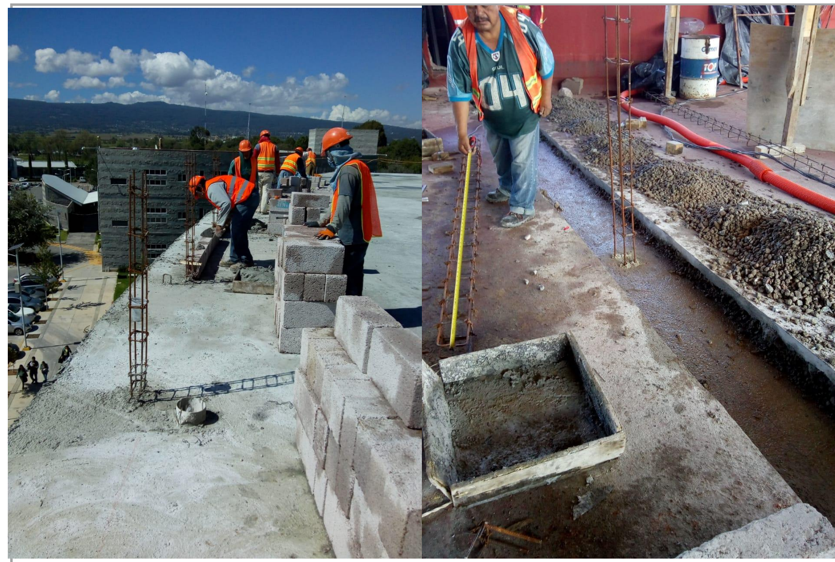
F1: DEMOLICIONES DE ENTORTADOS EXISTENTES Y CONSTRUCCIÓN DE MUROS DE BLOCK HUECO, CASTILLOS, CADENAS.
