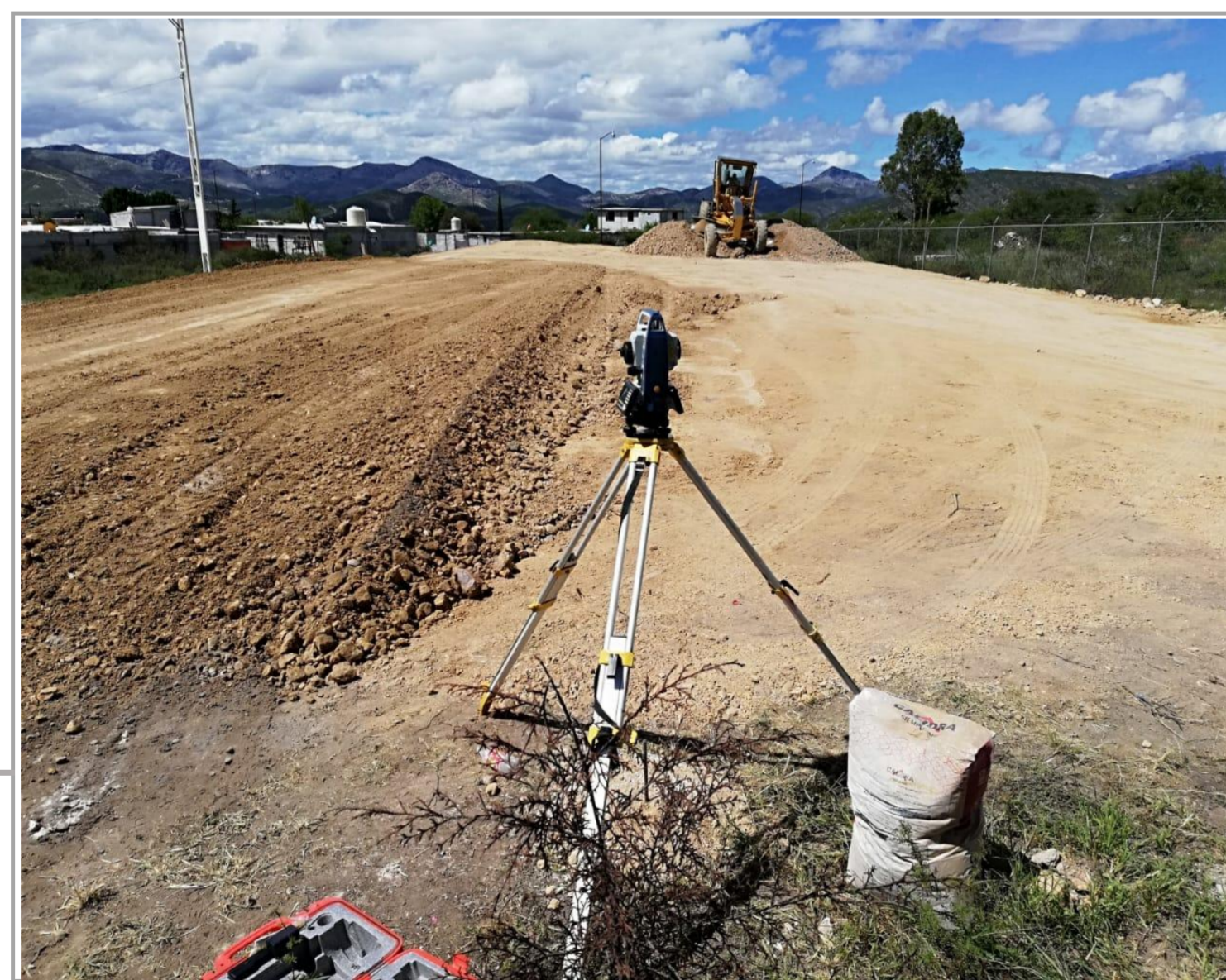
F3: CONFORMACIÓN DE PLATAFORMA DE TEPETATE (TRAZO Y NIVELACIÓN)
