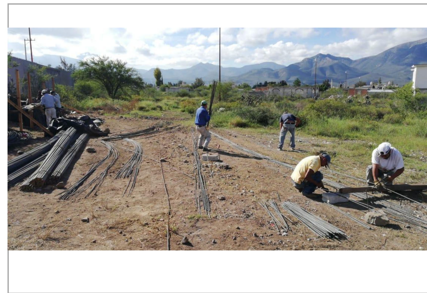
F4: SUMINISTRO Y HABILITADO DE ACERO
