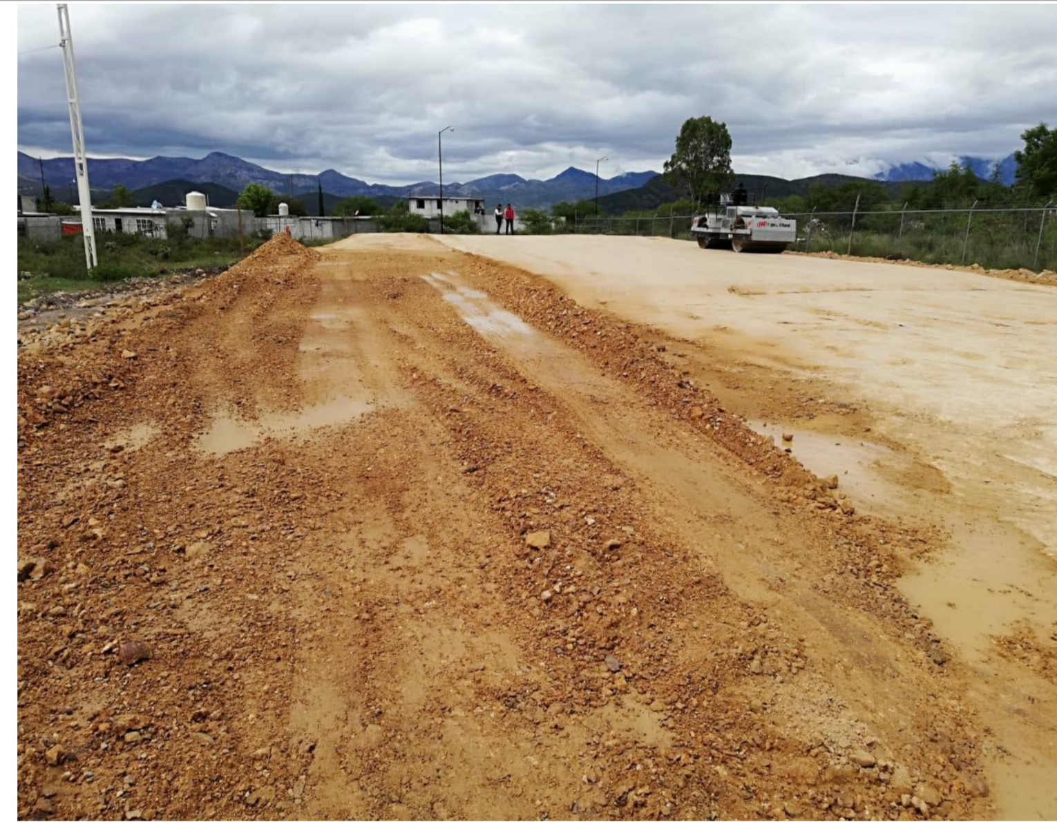
F1: CONFORMACIÓN DE PLATAFORMA DE TEPETATE (COMPACTACIÓN)
