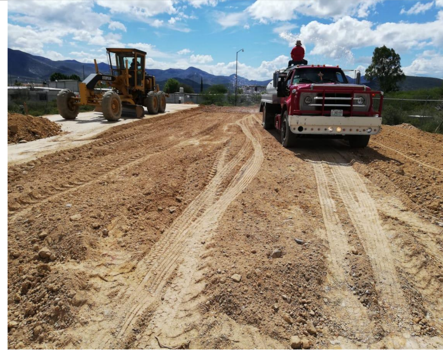
F2: CONFORMACIÓN DE PLATAFORMA DE TEPETATE (NIVELACIÓN)
