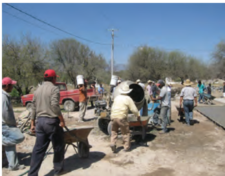
Pavimentación de calles durante las faenas
