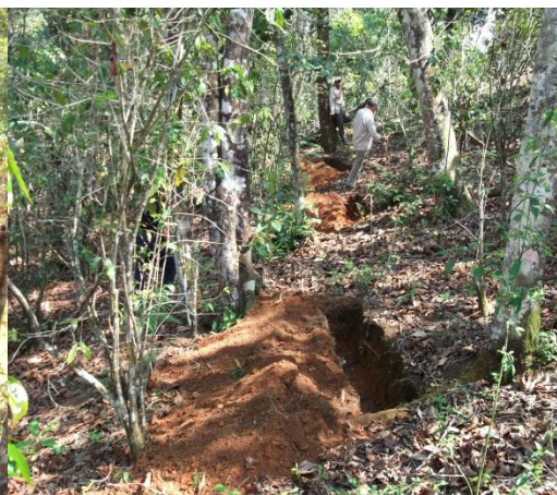
d) Zanjas trinchera
