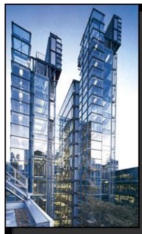
Edificio Lloyd, Londres. R. Rogers
