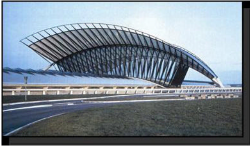
Aeropuerto de Lyon. Santiago Calatrava
