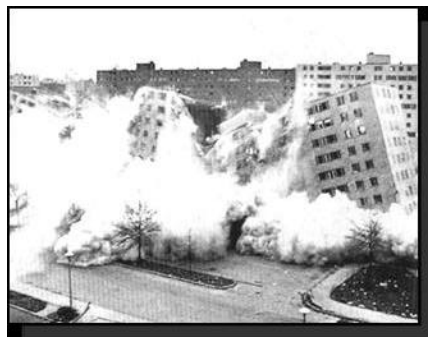
Demolición del Pruitt-Igoe, 1972, M. Vamasaki.
