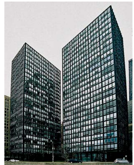
Viviendas de Lake Shore Drive. Chicago. 1948-1951 Mies van der Rohe
