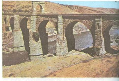
El puente de Alcántara (Cáceres). El arco triunfal sobre el pilar central está dedicado a Trajano
