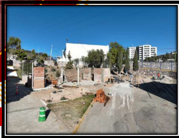
Construcción de gimnasio
