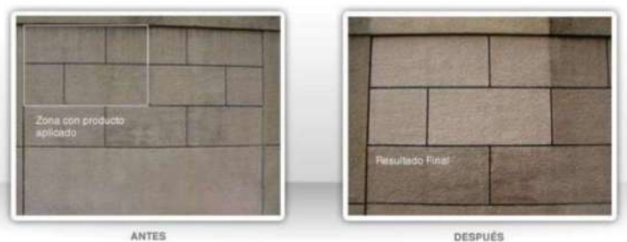
Figura 6. Auto limpieza de fachada tras aplicar un producto a base de nanopartículas de \text{TiO}_2
